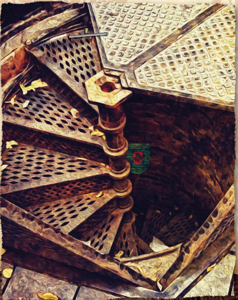
Einer der Einstiegsbereiche zur Ostlechter Kanalisation. Die Wendeltreppe wird weiter unten zu einer Leiter aus Eisensprossen
